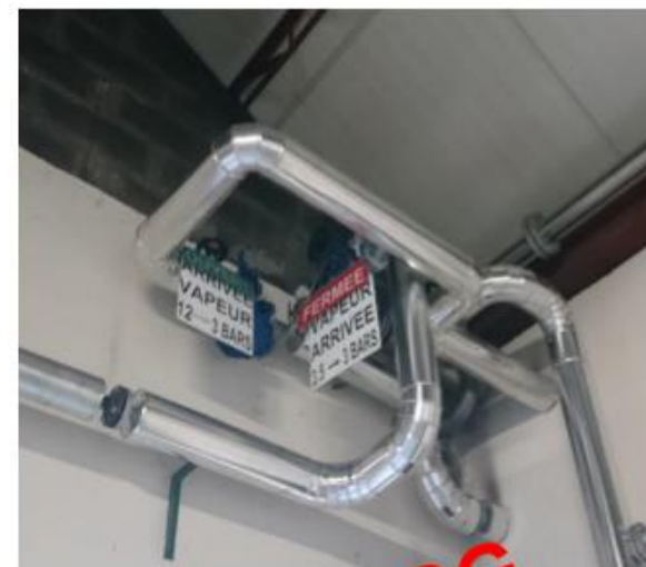
Modification réseau vapeur
