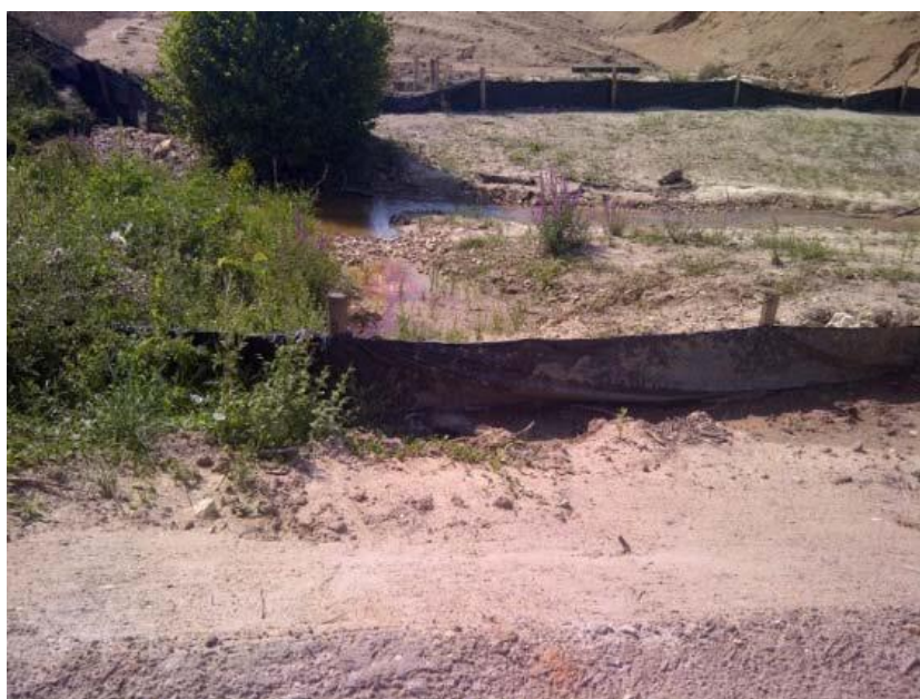
Exemple de clôture (source IMERYS REFRACTORY MINERALS CLERAC).
