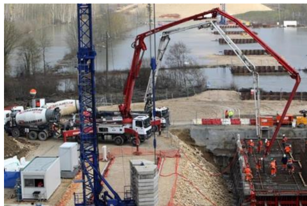
Chantier de la LGV SEA entre Poitiers et Bordeaux (2012-2014) :
