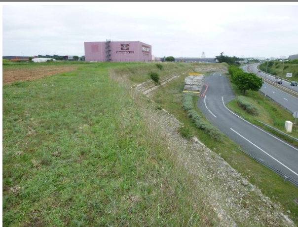
Sommet de talus de déblais. La végétation calcicole qui s'y développe héberge la plante protégée Odontites jaubertianus (septembre 2016)
