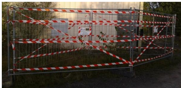
Figure 4 : Exemple de balisage d'une zone de mise en défend pendant un chantier
