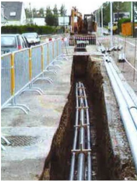
Pose en fourreau PVC enrobé de béton
