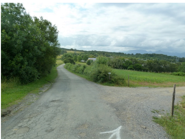
Croisement entre le Chemin d'Hariagaraya et la piste menant à Larregaina. Photo en direction sud.
