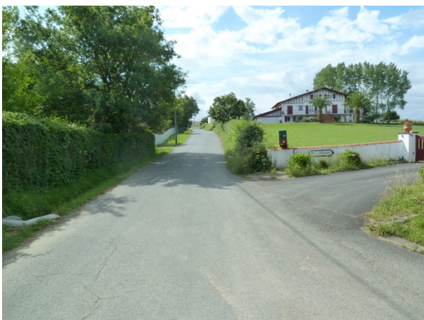
Croisement entre le Chemin d'Hariagaraya et le Chemin de Carricarta. Photo en direction sud.
