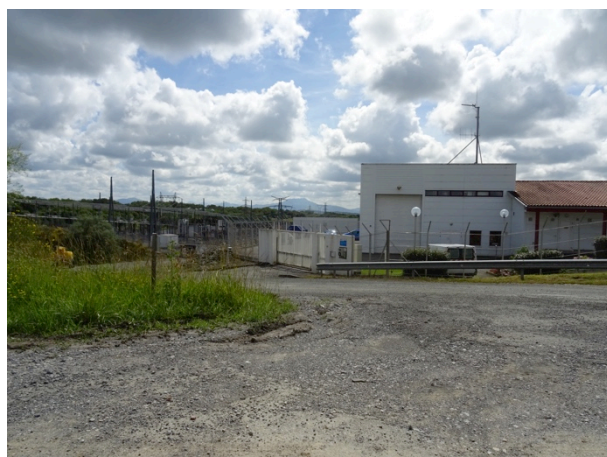
L'arrivée au poste d'ARGIA. Photo en direction sud-ouest.
