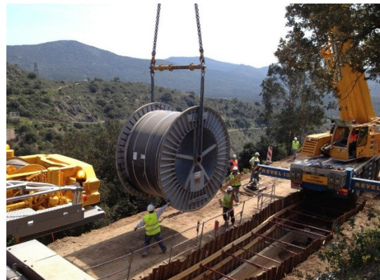
Manutention de touret par une grue
