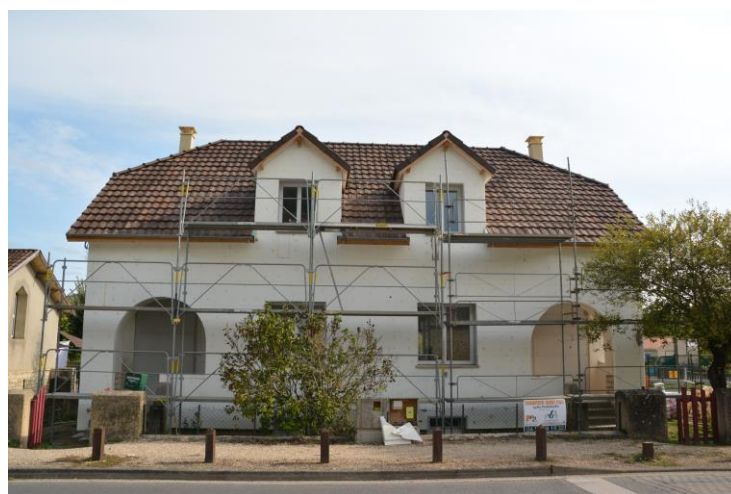
Figure 2 - Façade principale bâtiment « logements communaux Mouzens »
