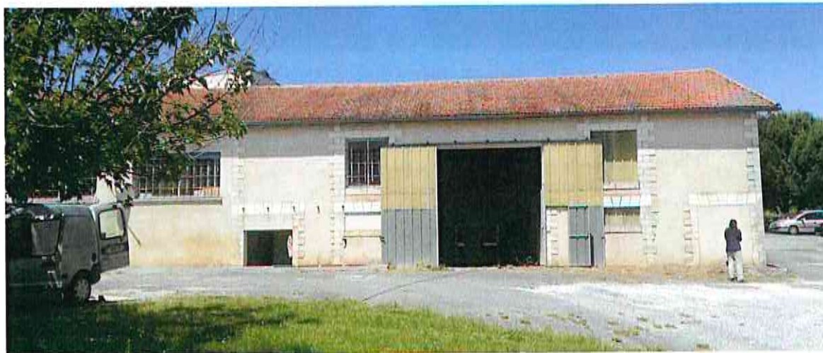
Figure 11: Façade sud du bâtiment 2
