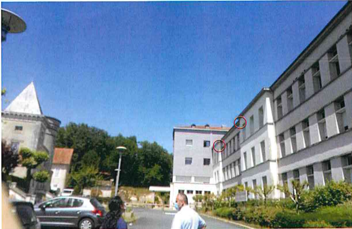
Figure 8 : Façade Ouest de l'hôpital
