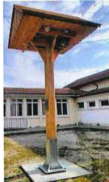
Figure 17 : Tour à hirondelle installée à Mios (33)
