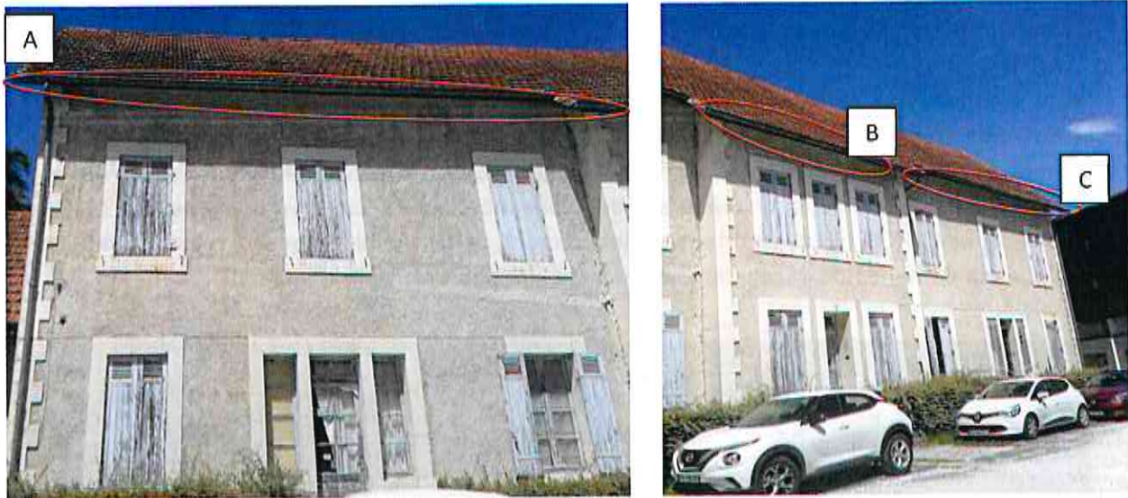
Figure 2 : Photographie de la façade Sud du bâtiment 1
