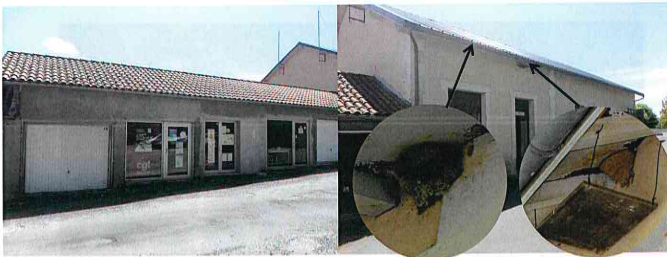
Figure 10 : Façade nord du bâtiment 2
