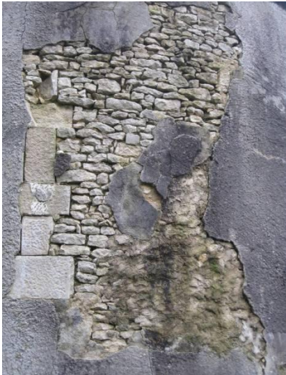
Façade nord-ouest de la citerne à eau.
