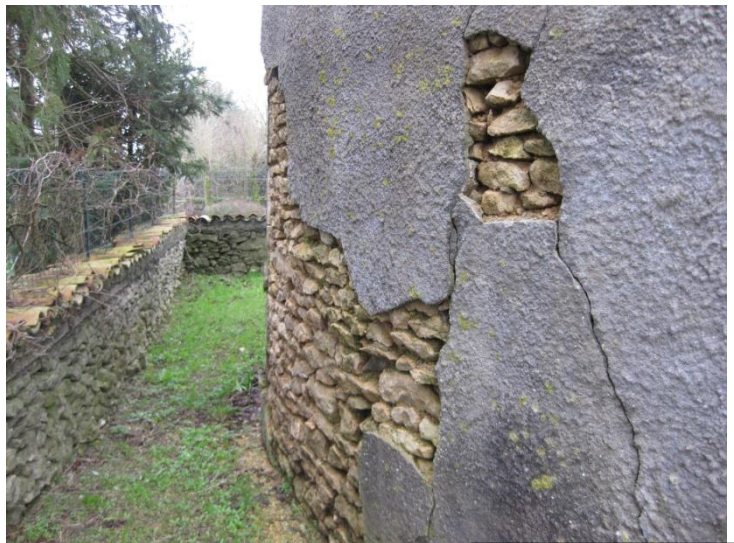
Façade nord-est de
