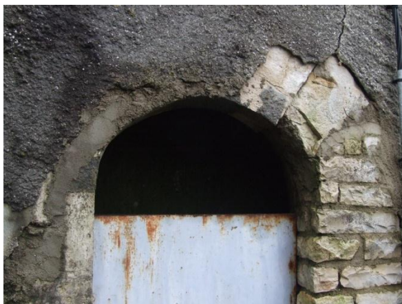
Porte d'entrée de la citerne à eau.
