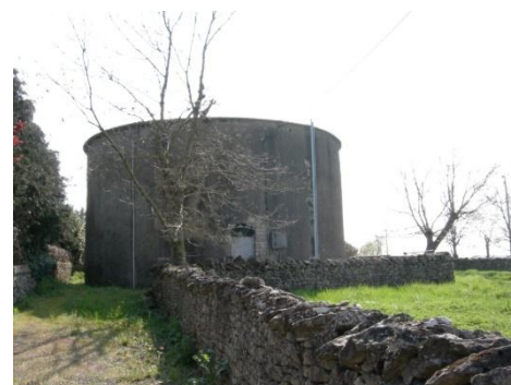
Figure 3 : Photo de la citerne à eau de Sainte-Ouenne.
