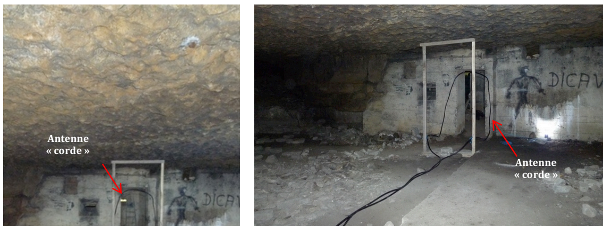
Figure 3 : Présentation de l'antenne de lecture automatique de transpondeur de St Michel-Le-Cloucq
