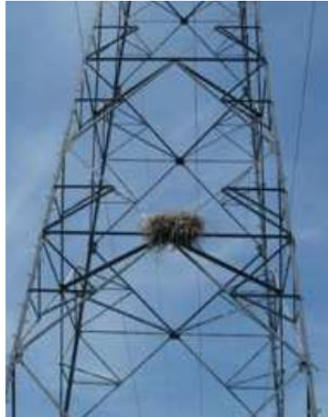
Figure 7 : Installation au milieu du fût (crédit photo : Jean-Yves Brié, ACROLA)
