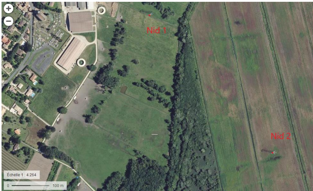
Figure 2a : Localisation et vue aérienne des différents pylônes poste haute tension utilisés (source : Géoportail)
