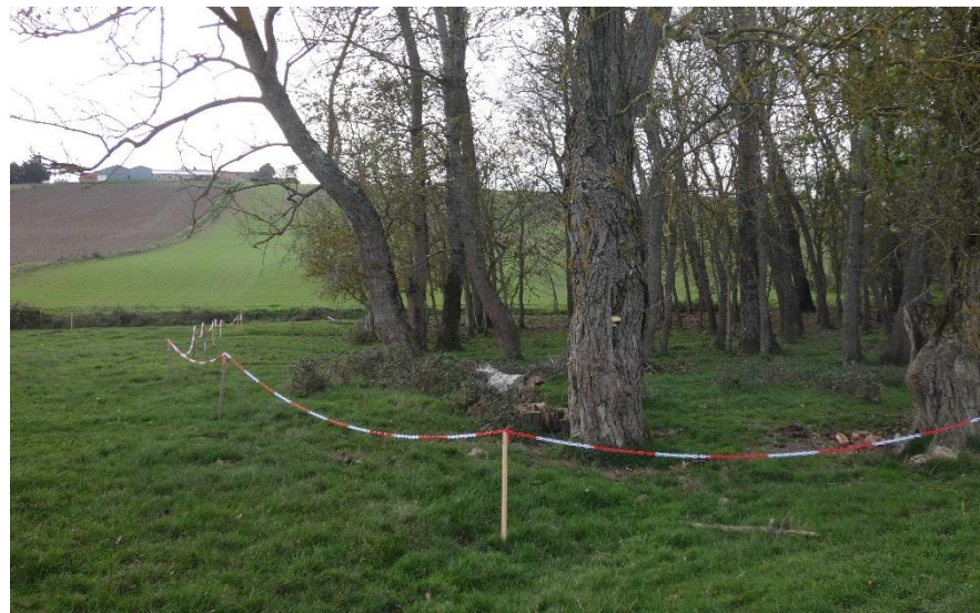
Exemple de balisage de chantier à l'aide d'une chaînette de chantier Nymphalis (photo prise hors de la zone d'étude)
