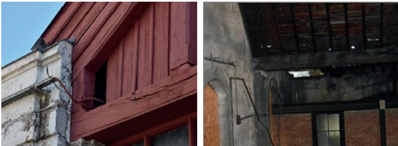
**Figure 15 : Illustration des brèches dans le bâtiment qu'il est prévu de calfeutrer**
