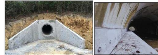
Tête de buse en béton coffré avec effet entonnoir (à gauche) et banquette fixée sur un ouvrage hydraulique (à droite) - (© VINCI Autoroutes)
