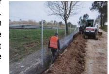
Mise en place d'un grillage renforcé. La partie basse est eenterrée - (© VINCI Autoroutes)
