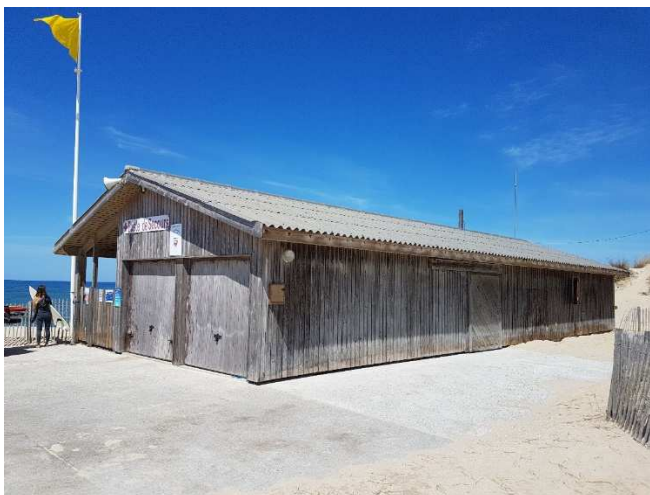
Photo 1- Poste de secours actuel (Source : ARTELIA)
