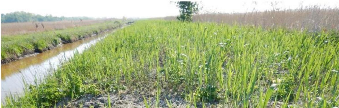
**Figure 18 : Exemple de restauration de berges : Reprise de la phragmitaie 6 mois après le curage et le reprofilage de la jalle de Gereyme (source Eau-Méga, 05/2017)**
