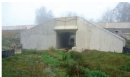
Chantier LGV Tours-Bordeaux, Estacade de la falaise, marais de la Virvée © DREAL Aquitaine - Arnaud Delbary
