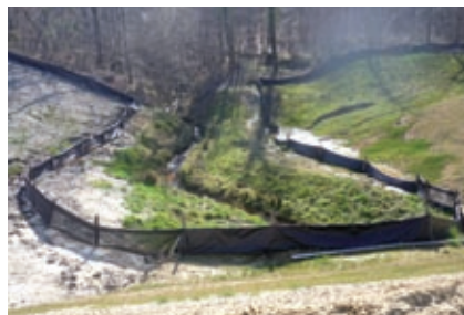
Mise en défens amphibiens, travaux SEA © DREAL Aquitaine - Arnaud Delbary
