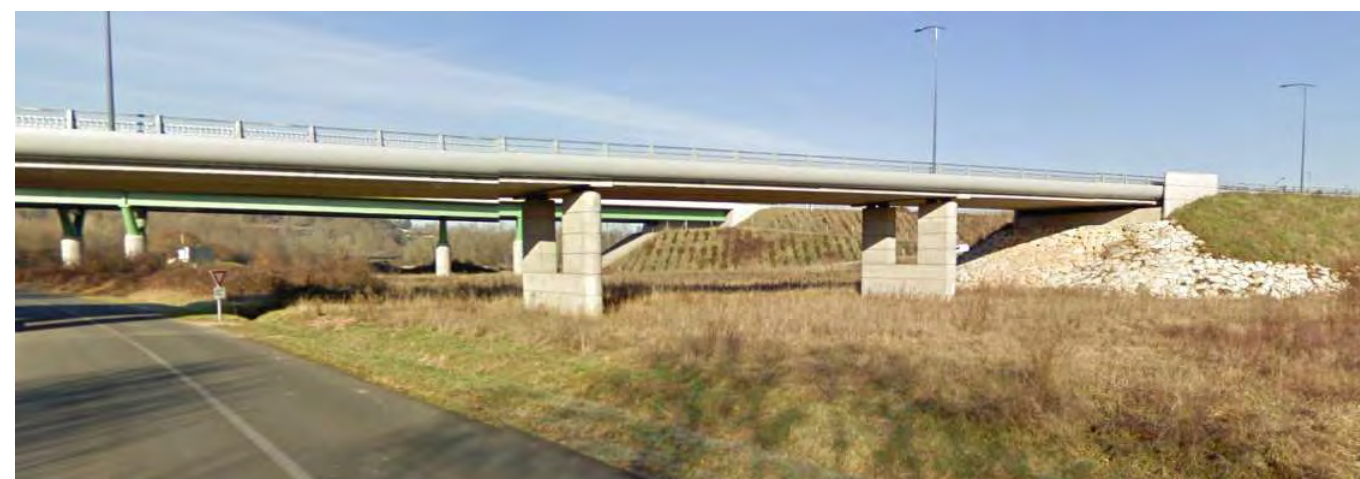
Ouvrage de franchissement de la RD 69 surmontant une partie de la zone de compensation
