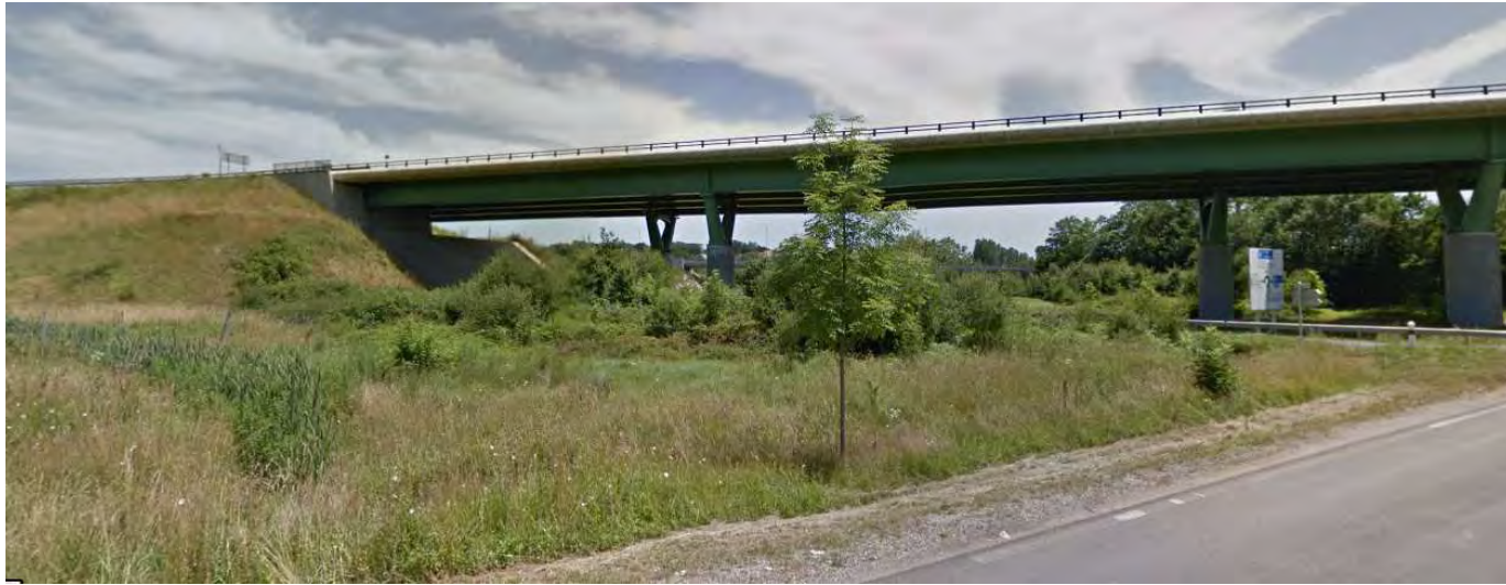
Ouvrage de franchissement de l'A89 dans le secteur de la zone de compensation, permettant la mise en place de corridors de déplacement entre les différentes vallées alluviales
