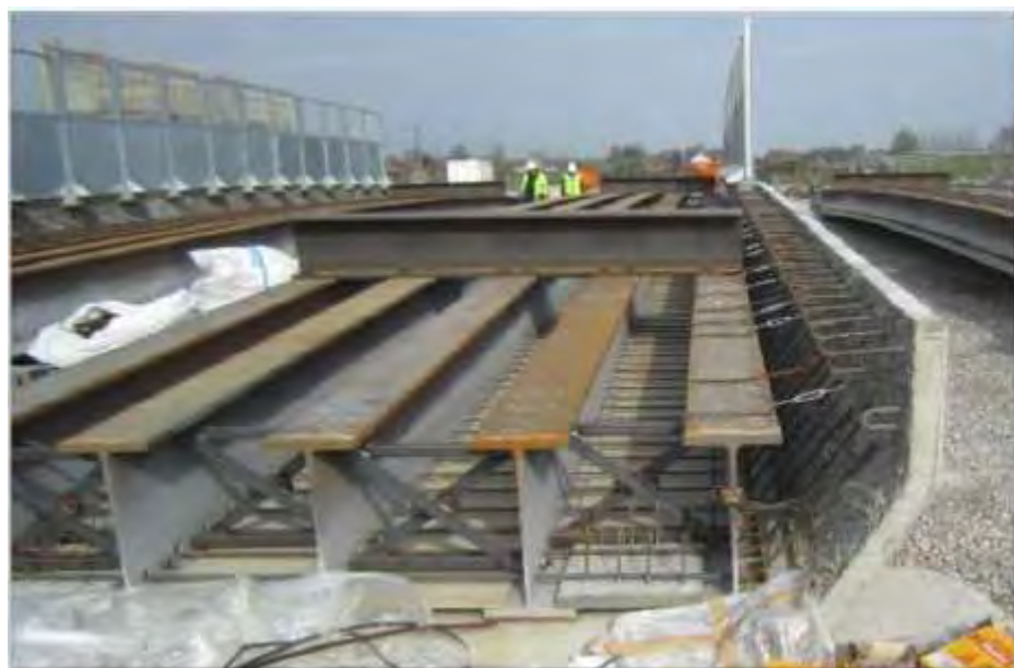
Illustration d'une structure de type tablier à poutrelles enrobées
