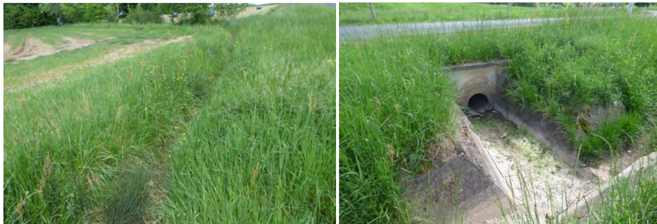
Fossés de collecte des eaux pluviales et tronçon busé passant sous la voirie
