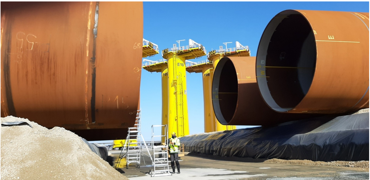
Les fondations d'éoliennes destinées au champ offshore de Saint-Nazaire en transit sur le port de La Rochelle
