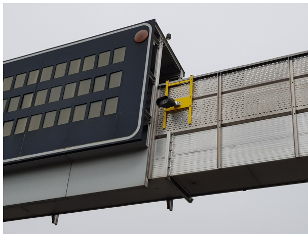
Illustration 6: Caméra fixée sur un portique PMV
