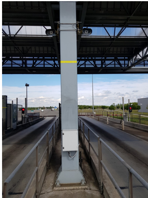
Illustration 7: Caméras fixées entre les deux voies PL
