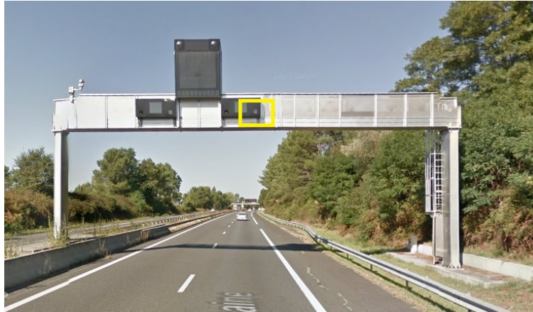
Illustration 5: Caméra intégrée dans le caisson vidéo
