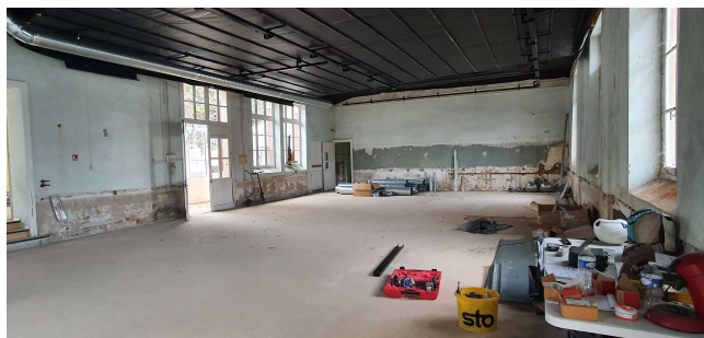
Ancienne salle de sport en cours Future salle polyvalente et bar associatif
