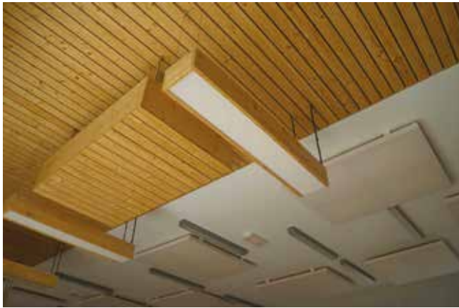
Caissons de confort acoustique en bois. © B.I.P / Bureau d'Intervention sur le Paysage.
