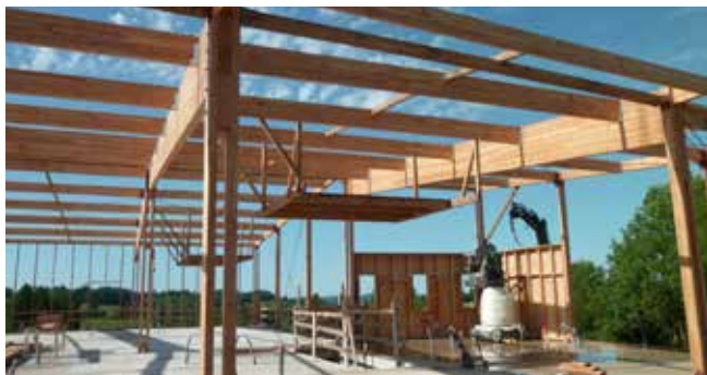
Structure bois en lamellé-collé. © FIBOIS Nouvelle-Aquitaine.
