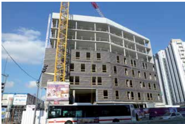
Façade ossature bois sur structure béton. © Hervé Vincent architecte.
