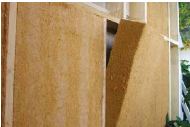
Ossature bois isolée de laine de bois. © Rénov'Charpentes.
