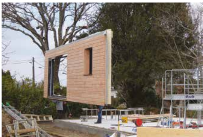
Grutage d'un mur ossature bois préfabriqué en atelier. © FIBOIS Nouvelle-Aquitaine.
