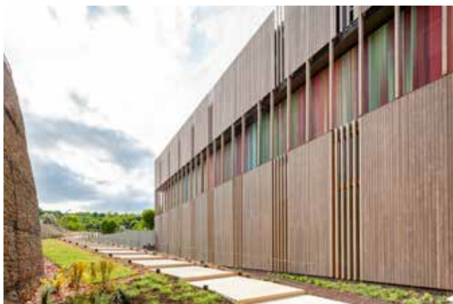
Bardage à claire-voie pré-grisé. © Terreneuve Architectes / Daniel Rousselot.
