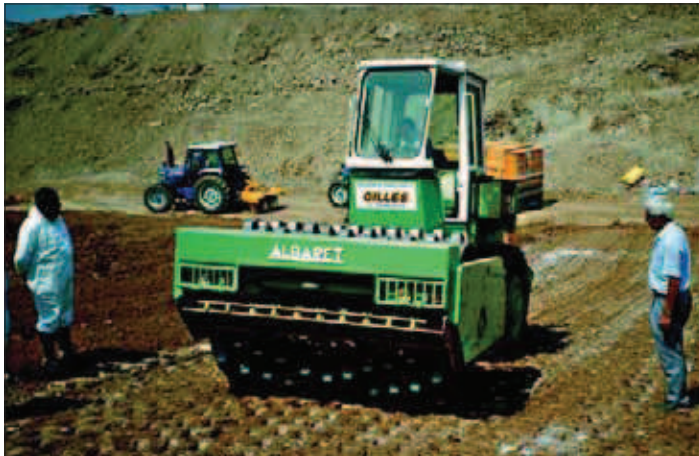
◀ 8 - Compactage au rouleau vibrant à pied de mouton (la scarification comme ci-dessus est inutile dans ce cas) (texte p. 102).
