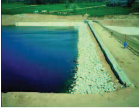
13 - Revêtement en terre végétale du parement aval du même barrage. Noter la présence d'une risberme (texte p. 77).
