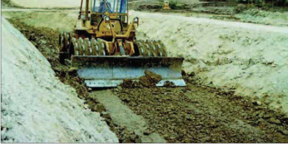
▲ 1 - Compactage d'argile dans la clé d'étanchéité (texte p. 71).
