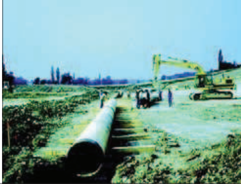
◀ 17 - La tranchée est emplie de béton.
