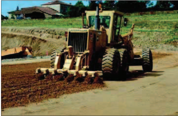
◀ 7 - Scarification après passage d'un rouleau vibrant lisse (texte p. 102).
