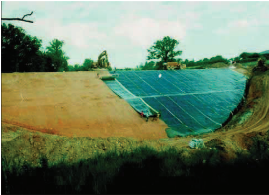
▲ 10 - Mise en place d'une géomembrane bitumeuse (texte p. 81).
