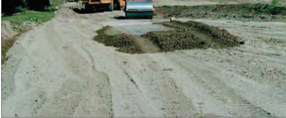
▲ 3 - Planche d'essai d'un très petit barrage (au fond le compacteur à rouleau lisse et une décapeuse qui amène la terre depuis la zone d'emprunt (texte p. 102).
