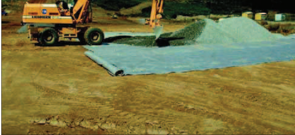
▲ 9 - Géotextile anticontaminant sous un drain horizontal en graviers (texte p. 79).
