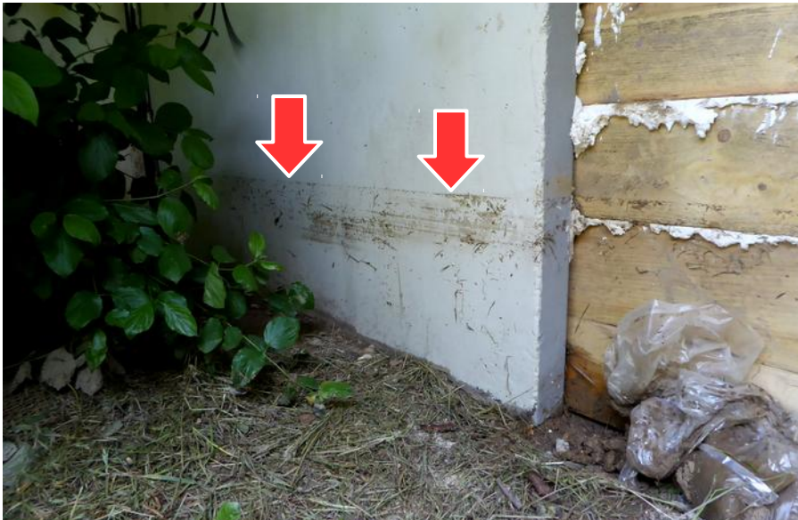
Exemple de marque trouvée à l'écart du lit mineur, dans un chenal d'écoulement obturé
