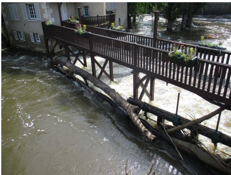
Exemple de constatation à noter : présence d'embâcles sous une passerelle, générant une surélévation du niveau de l'eau à l'amont
