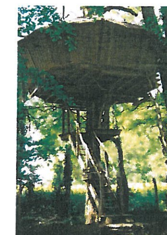
08 Cabane des Robinsons (pour 3 personnes) : Située en lisière de forêt, elle est accessible par un escalier à 6 mètres de hauteur. 1 lit double et 1 petit lit simple (80 x 160 cm).
