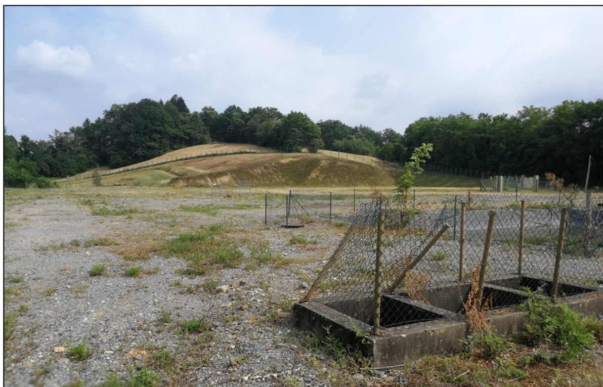
photo.3: vue générale du site : au premier plan, regard de réseau et au second plan le bournier Est bétonné.
