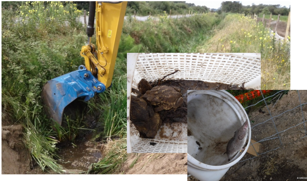
Fig.5: mise en œuvre des techniques de griffage
