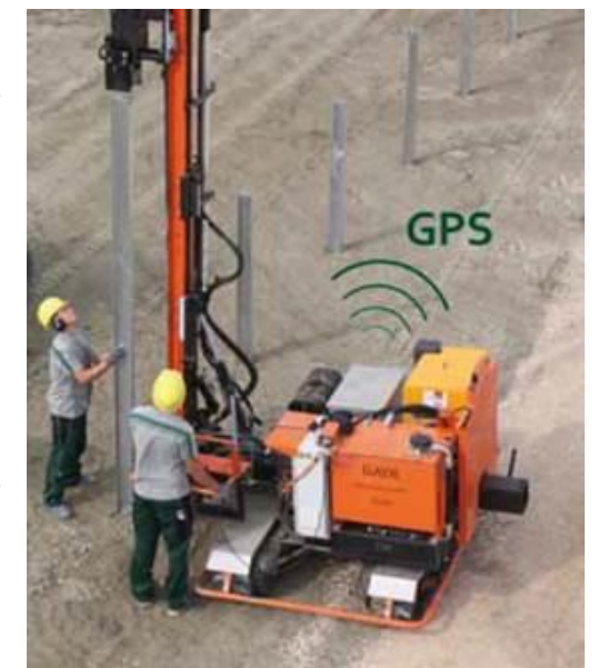
Illustration 2 : ancrage au sol par pieux battus
