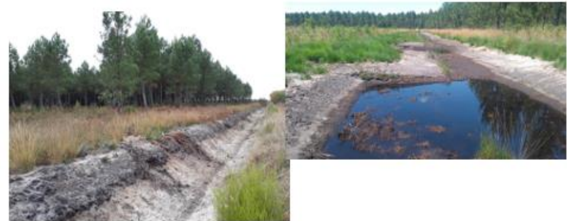
Figure 14 : A gauche : fossé forestier de drainage classique à Solférino. A droite fossé reprofilé dans un site de compensation des Landes : profil rehaussé et élargi avec création de seuils et de zones de surverse dans les parcelles.
