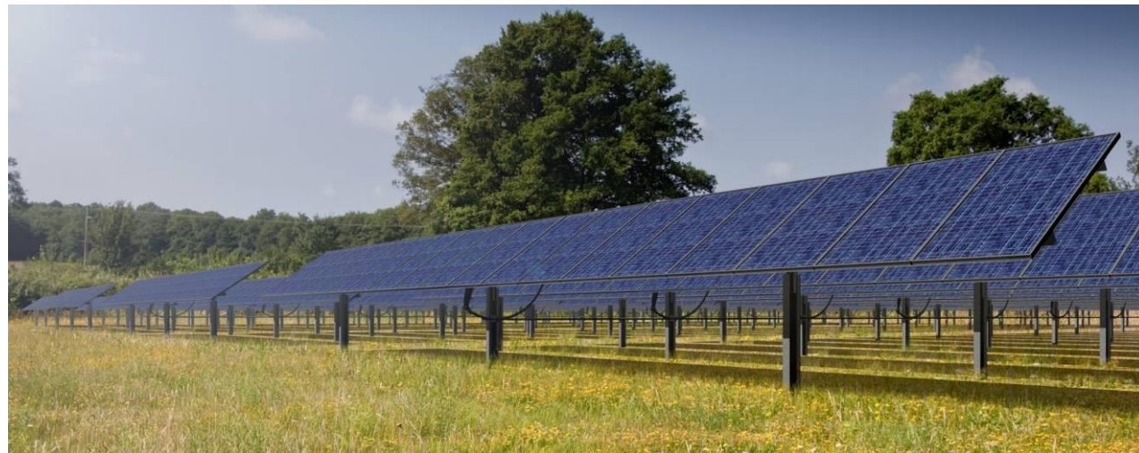
Une rangée de trackers (Source : Exosun)
