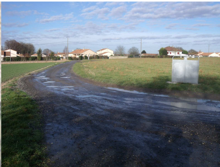
CR n° 22 – accès sur la section réalisée en 2008
