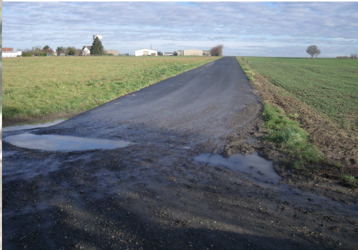
Extrémité de la section réalisée en 2008
