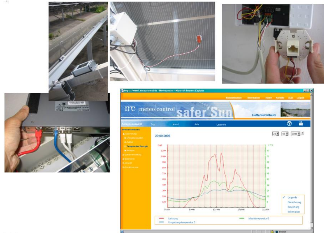
Mise en place du système de monitoring
