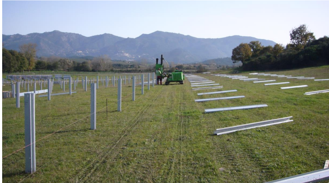
Exemple de mise en place de pieux battus (source : NEOEN)
