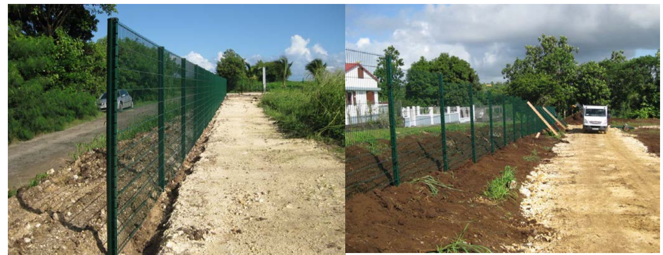
Implantation et pose de la clôture en acier galvanisé à mailles soudées
