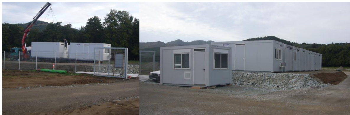
Mise en place des installations de chantier : ici, les bâtiments ont été surélevés car ils sont situés dans une zone susceptible d'être inondée
