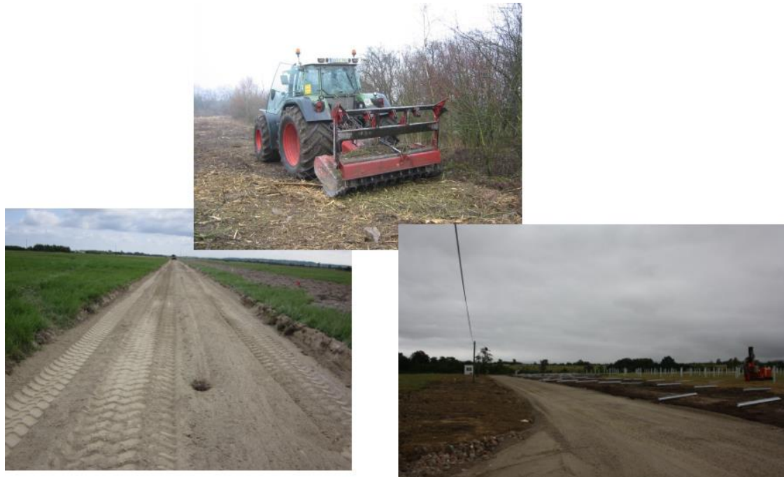
Terrassement et réalisation des pistes d'accès
