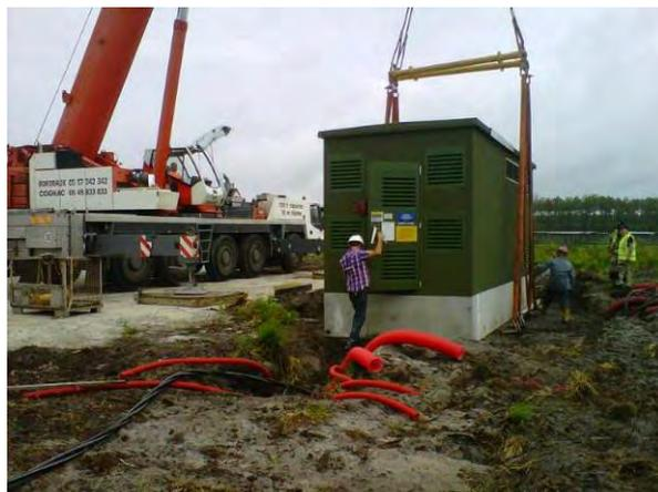
Photo 3 : Exemple de transport d'un poste de livraison
