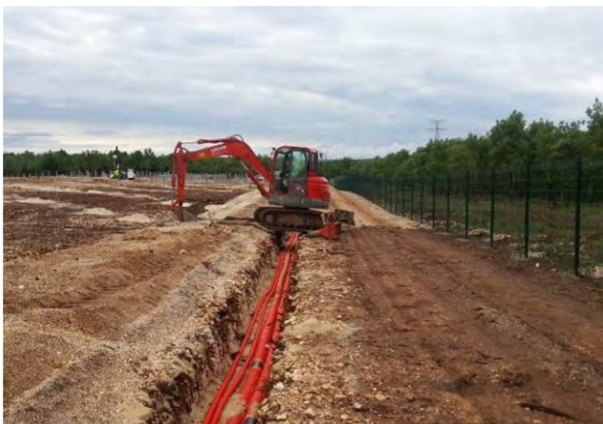
Photo 1 : Construction du réseau électrique
