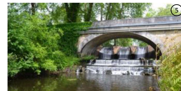
Vue du barrage depuis l'aval (© ISL, 14/05/2018)
