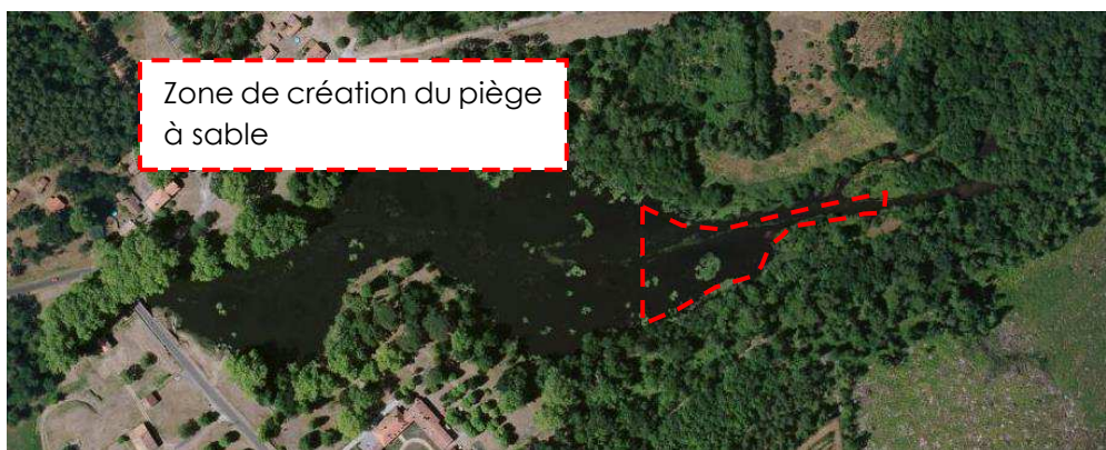
Figure 11 : Vue de l'étang après dragage avec piège à sédiments en amont
