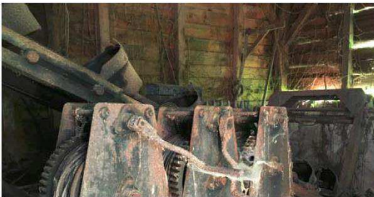
Figure 1: Engin de dragage mécanique historique encore présent sur le site des Forges (drague à godets)
