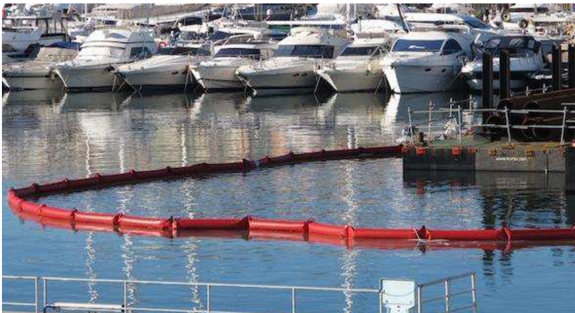
Figure 25: Mise en place barrage-barrière filtrant MES pour travaux maritimes (© Difope)
