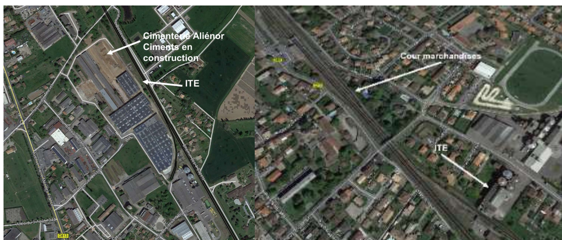
Figure 35 : ITE de Ferron (à gauche) la cour marchandises et l'ITE de Tonneins (à droite)
