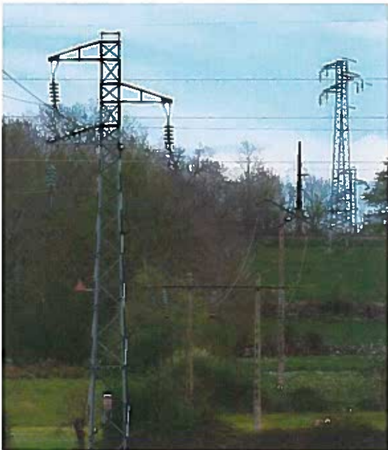
Vue d'ensemble des pylônes 21, 22, 23 et 24
