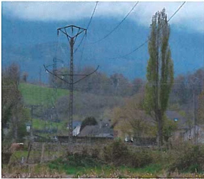
Pylône n°19 (vue extérieure du lotissement de Buzy)
