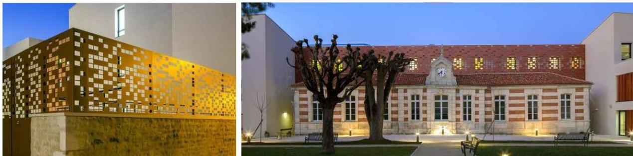
Figure 20 : Exemples de réalisation de maille perforée (source : MSP de Bordeaux-Bagatelle)
