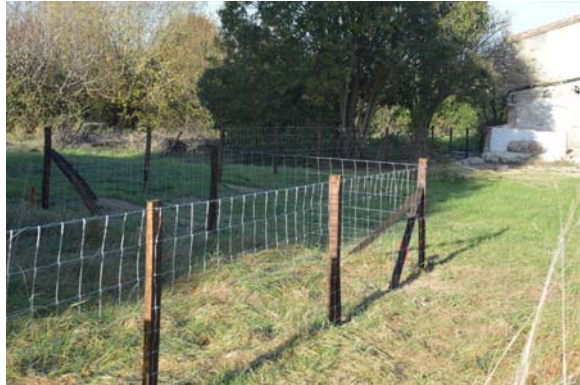
Figure 1 : Clôture chantier (Source : ENVOLIS)
