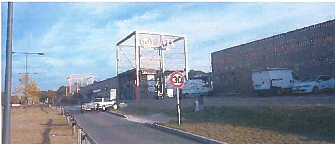
Figure 10 : Photographie du bâtiment Leclerc bâti présent au Sud du site du projet (02/11/17)
