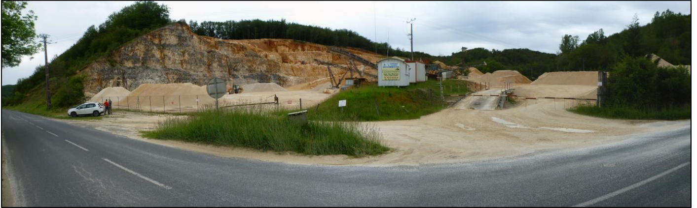
Vue 1 : Vue de l'entrée du site depuis la RD62 L'Artifex – 22 mai 2017
