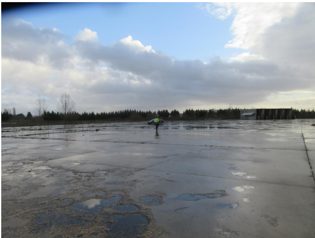
Photographie 2 présentant la plateforme imperméabilisée destinée à accueillir la zone d'implantation du projet – Direction Nord-Est
