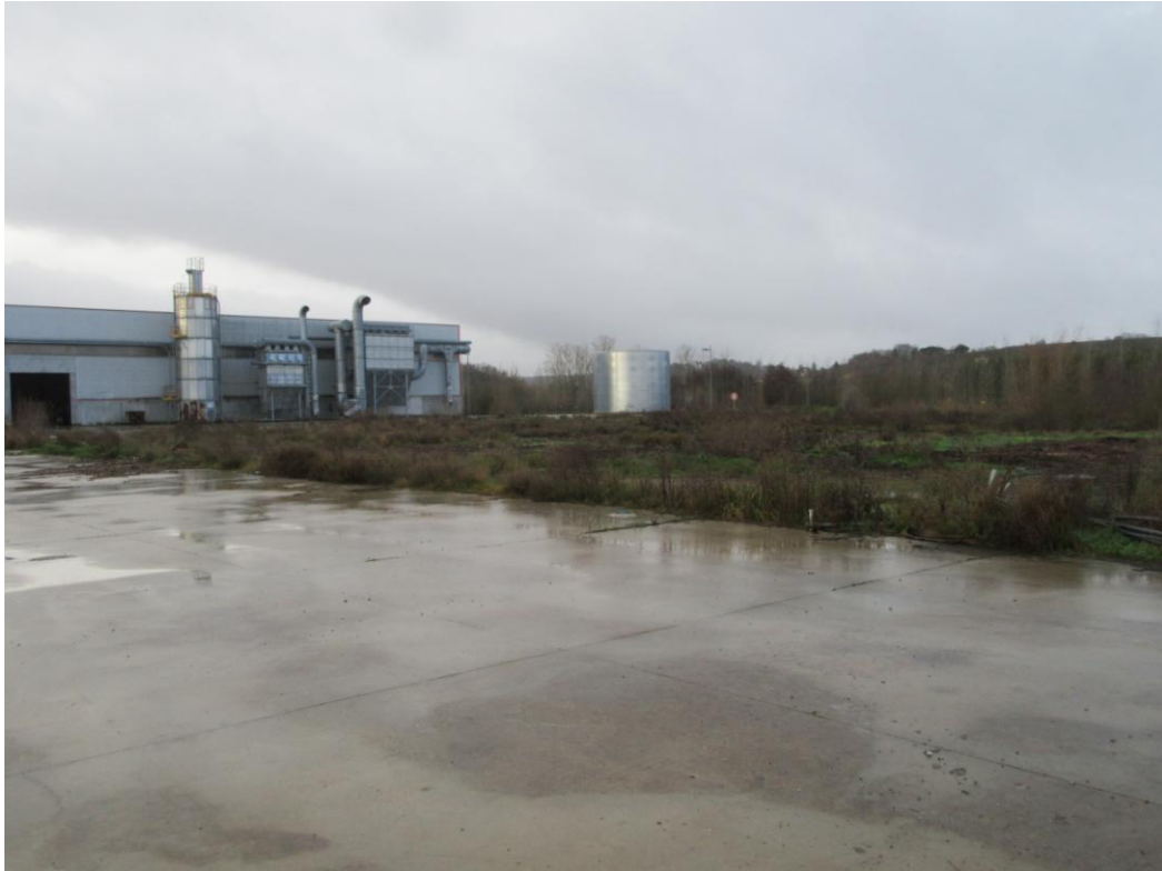
Photographie 6 - Plateforme bitumée en friche localisée à l'Ouest de la zone d'implantation du projet
