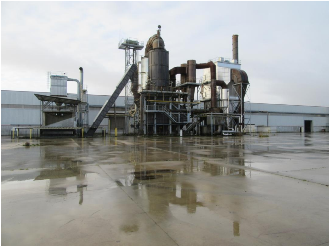
Photographie 5 - Bâtiment central Valorizon avec vue sur une ancienne chaufferie biomasse non utilisée, localisée au Sud de la plateforme imperméabilisée
