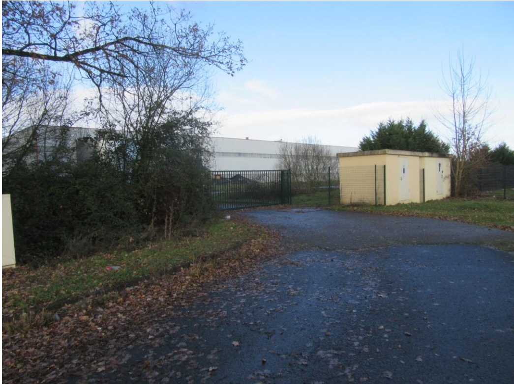
Photographie 1 - Vue en direction de la plateforme destinée à accueillir le projet, depuis la voie longeant l'entreprise Ambonati
