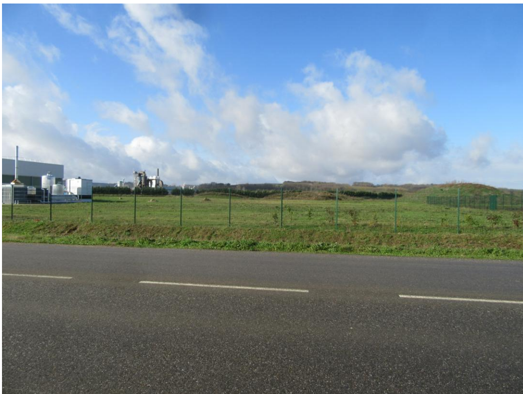
Photographie 3 - Vue en direction de la zone d'implantation depuis la route desservant la ZAE de la Confluence II, au niveau de l'entreprise Bioviver
