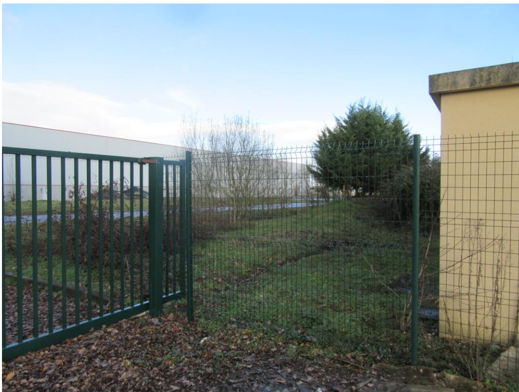
Portail d'accès situé sur le côté Est du site Valorizon
