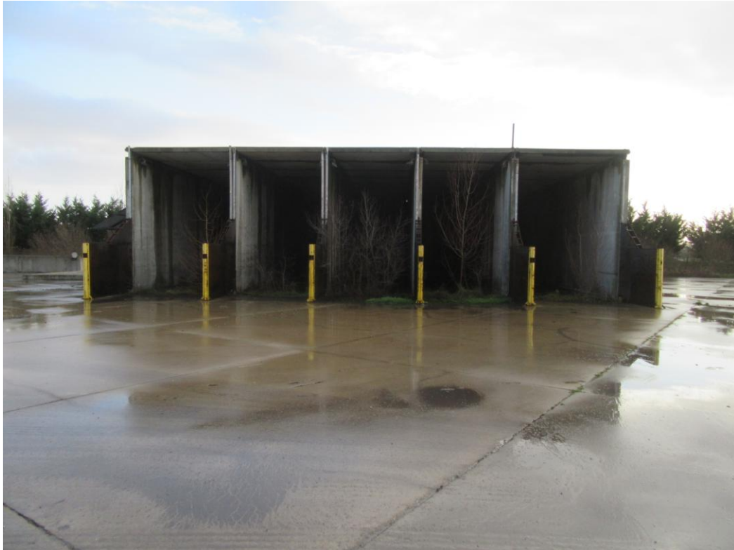
Anciens casiers béton non utilisés localisée à l'Est de la plateforme imperméabilisée
