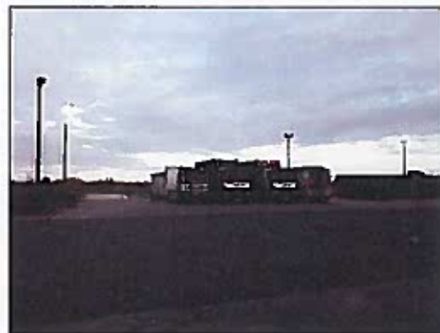
PHOTOGRAPHIE N°2 Vue lointain Depuis l'aire de lavage extérieure
