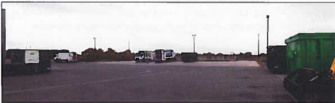
PHOTOGRAPHIE N°4 Vue proche - Depuis la Hall de Transfert incendiée
