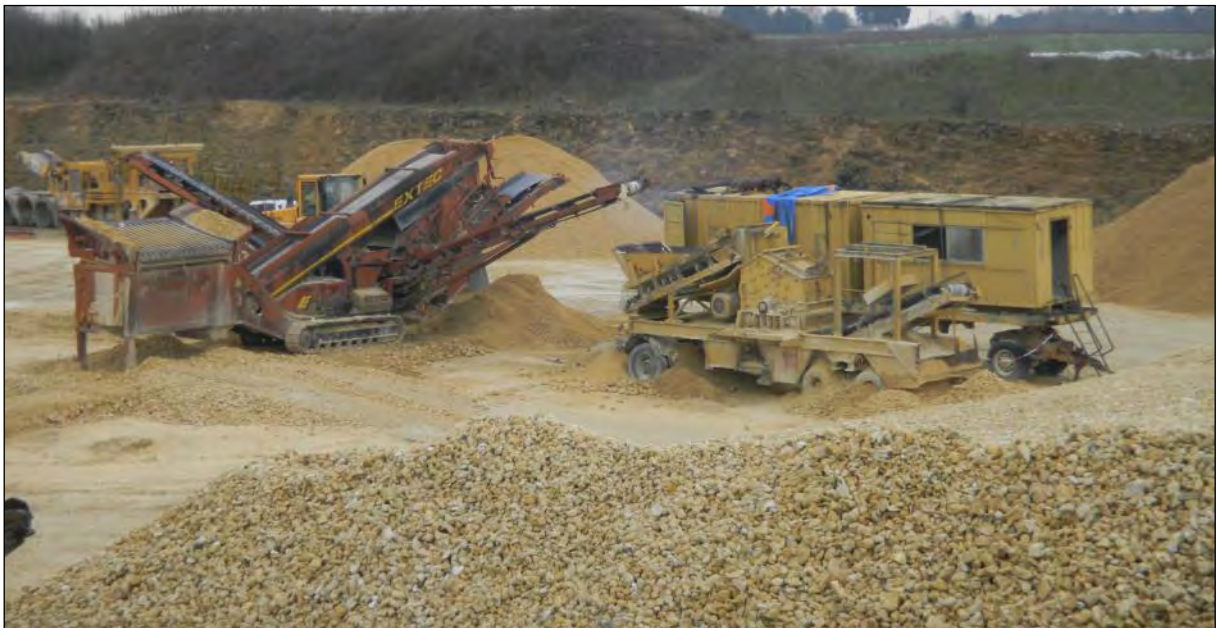
Figure 12 : Vue de l'unité de traitement mobile du site ETATP (source EODD)
