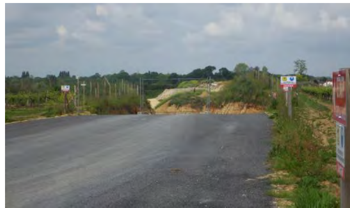
Entrée de la RD139 vers la centrale d'enrobage
