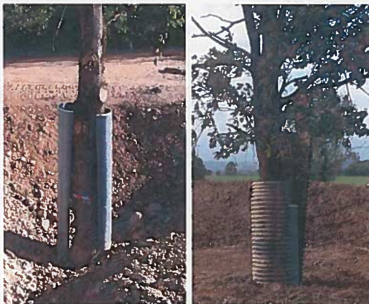
Figure 15 : A gauche, protection non efficace (demi-tubes de diamètre trop petit) ; A droite, renforcement du système précédent avec deux demi-tubes plus larges (protection efficace).
