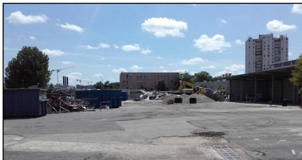
Photographie 1 : Site en cours de démolition (source : BURGEAP)
