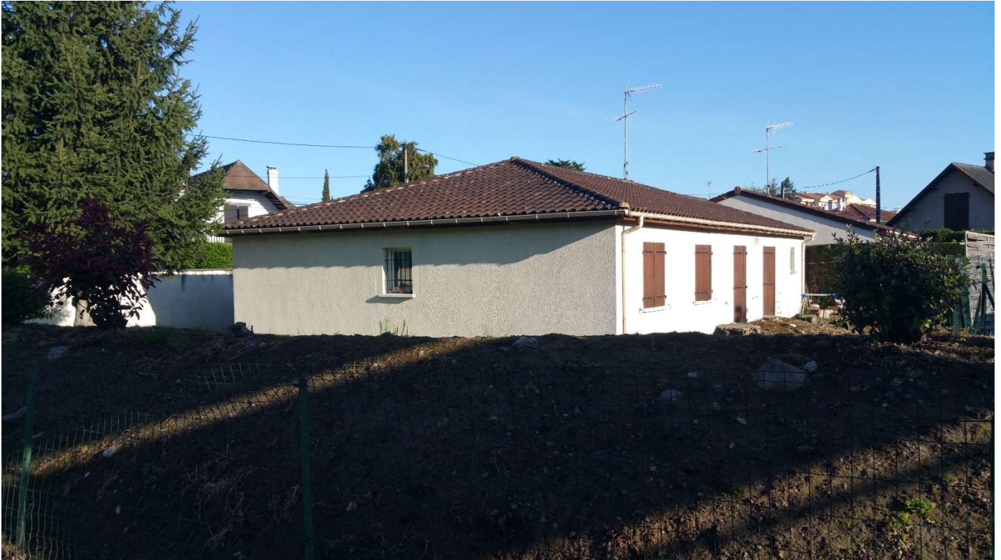
Photo 4 : Maison d'habitation à démolir
