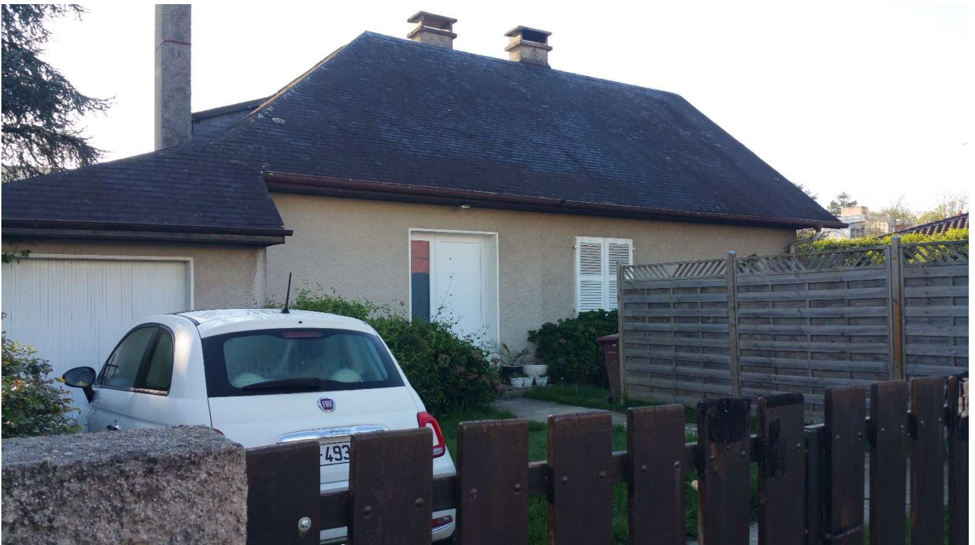
Photo 5 : Maison d'habitation à démolir
