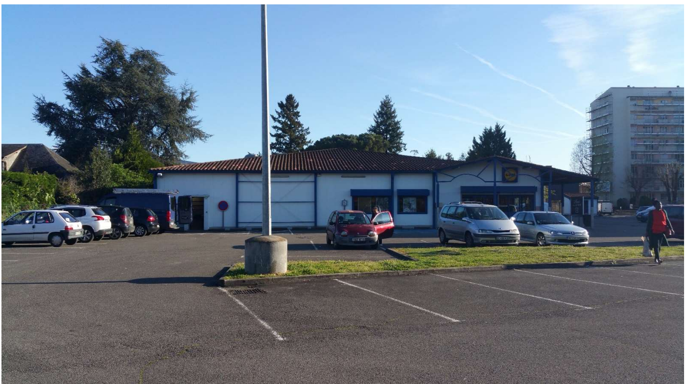
Photo 1 : Le magasin existant vu du Sud
