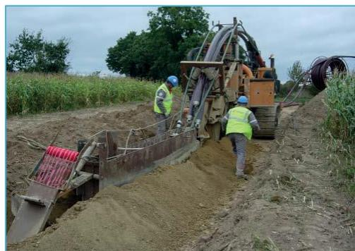
Mise en place de fourreaux PEHD en zone agricole à l'aide d'une trancheuse
