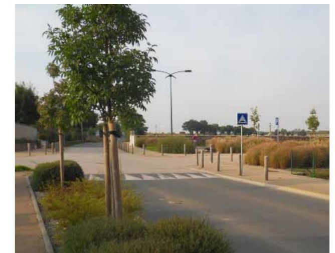
Sécurisation de la traversée piétonne : plateau piétonnier surélevé et revêtement en résine
