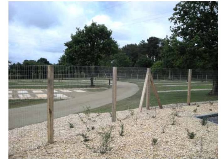
Clôture métallique et piquets châtaignier
