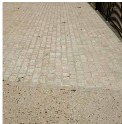
Pavage et béton désactivé
