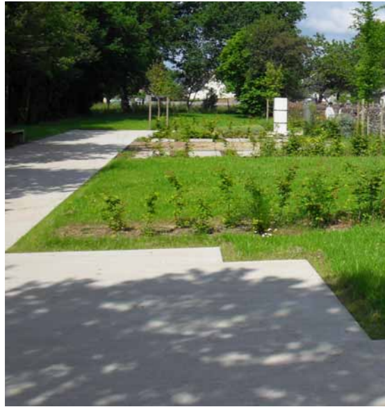
Allée principale en béton balayé
