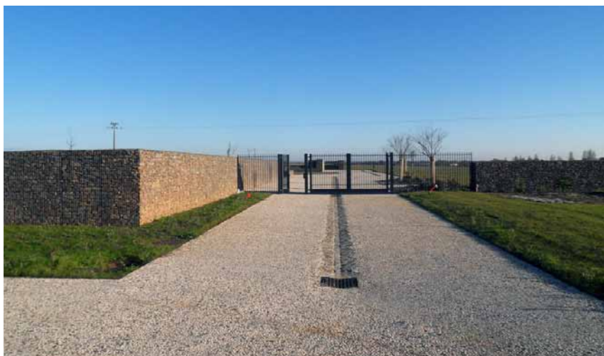
Circulation en béton désactivé
