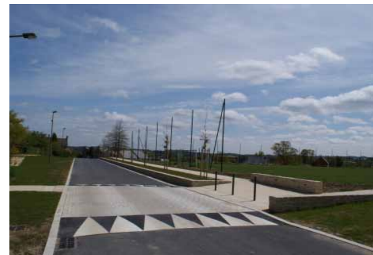
Sécurisation de la traversée piétonne : plateau piétonnier surélevé et revêtement en résine
