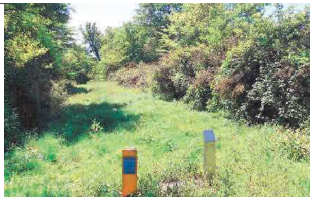
5 : Passage de gazoduc en limite sud du site (04/2017)
