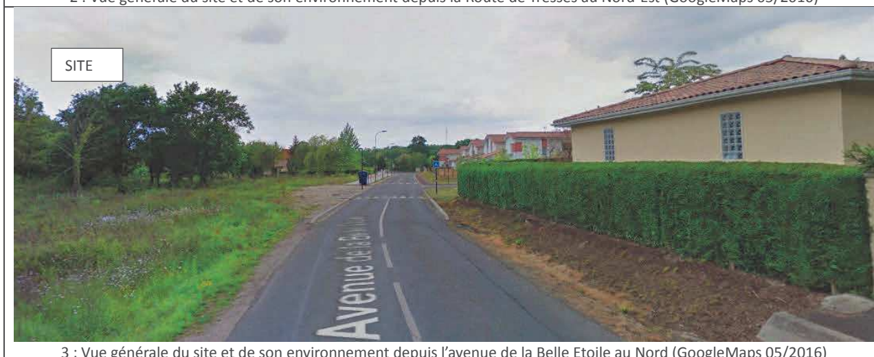
3 : Vue générale du site et de son environnement depuis l'avenue de la Belle Etoile au Nord (GoogleMaps 05/2016)
