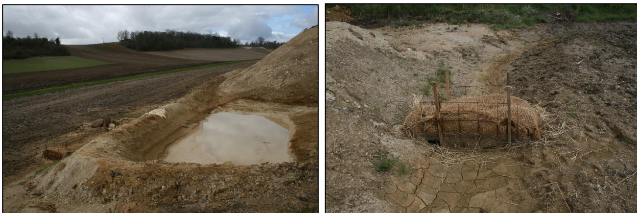
Figure 10 : bassin de décantation temporaire des eaux de ruissellement en phase de chantier avec filtre à paille en sortie
