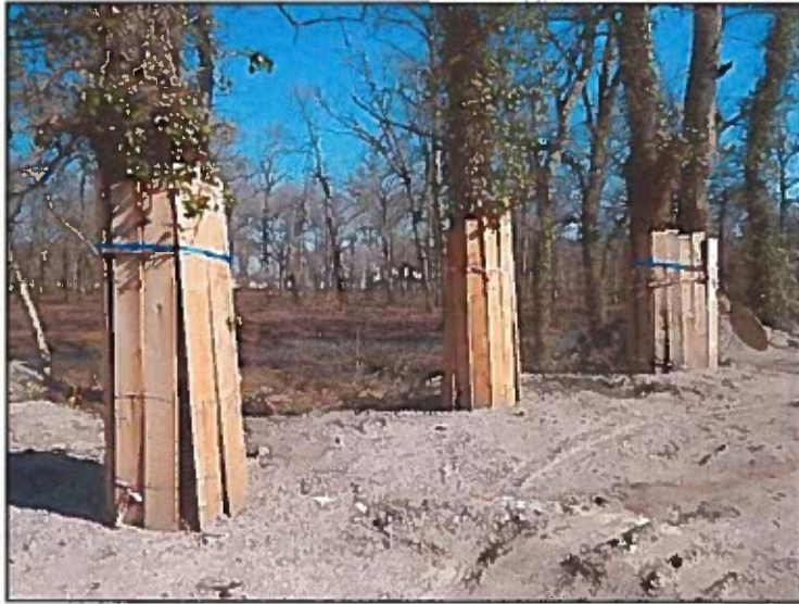
Dispositif de protection des arbres remarquables sur chantier (Source : ENVOLIS)
