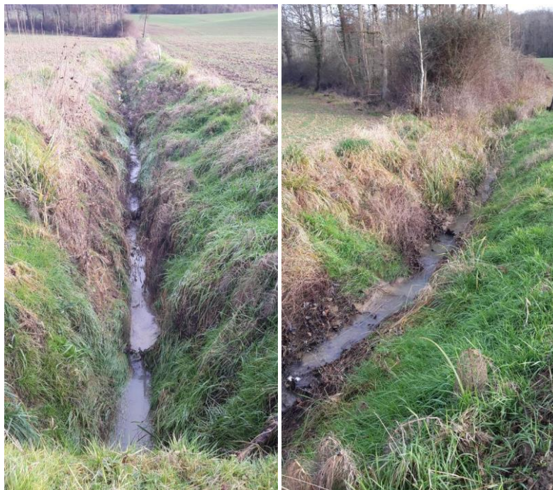
Berges abruptes en aval (à gauche) et plus douce et végétalisée en amont (à droite) © ETEN Environnement
