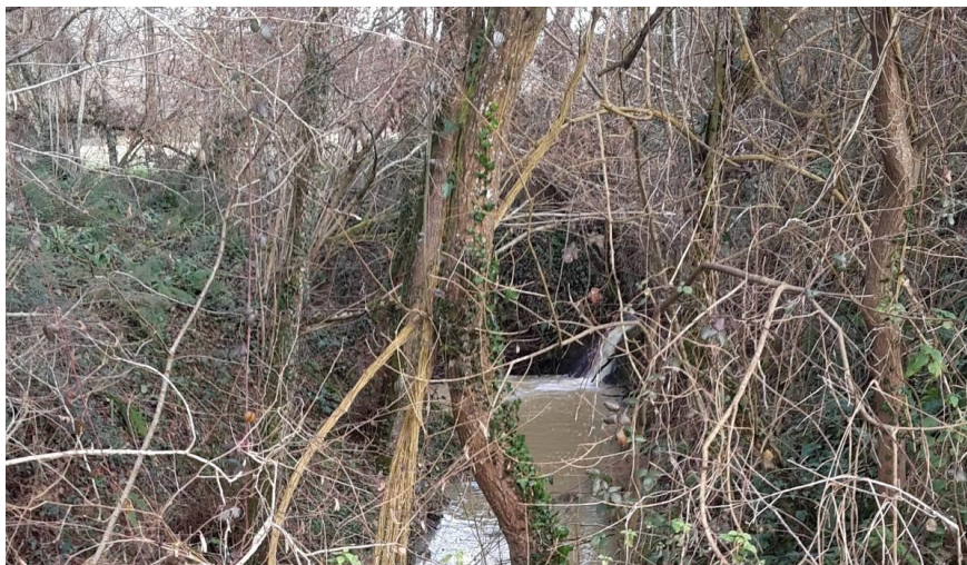
Seuil naturel sur le ruisseau du Pouy © ETEN Environnement – 24-01-2019
