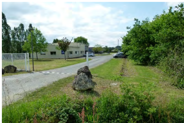
Les locaux de la Régie d'Electricité
