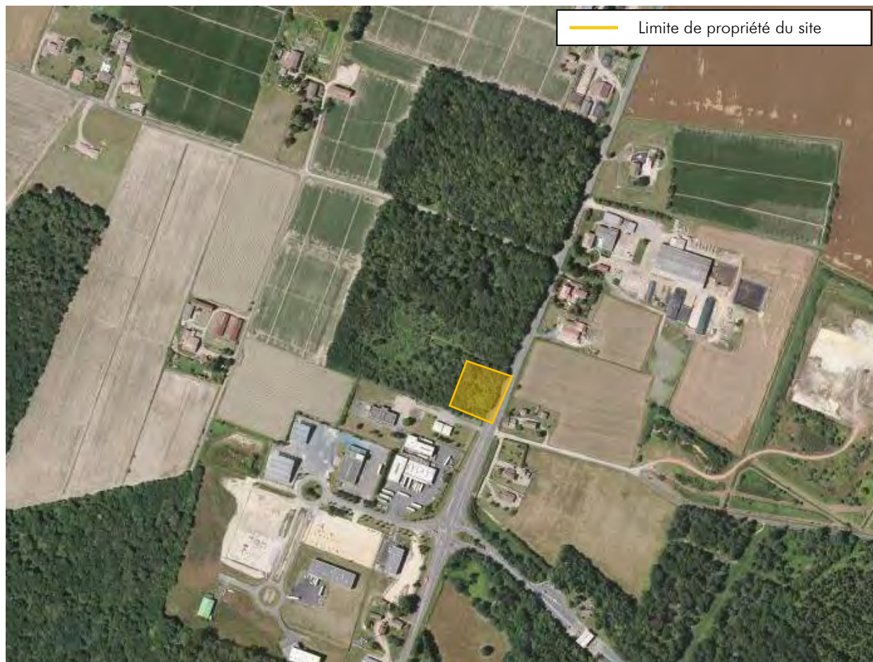
Localisation du site dans son environnement
