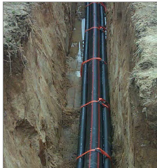
Exemple de pose en fourreaux PEHD - Liaison simple
