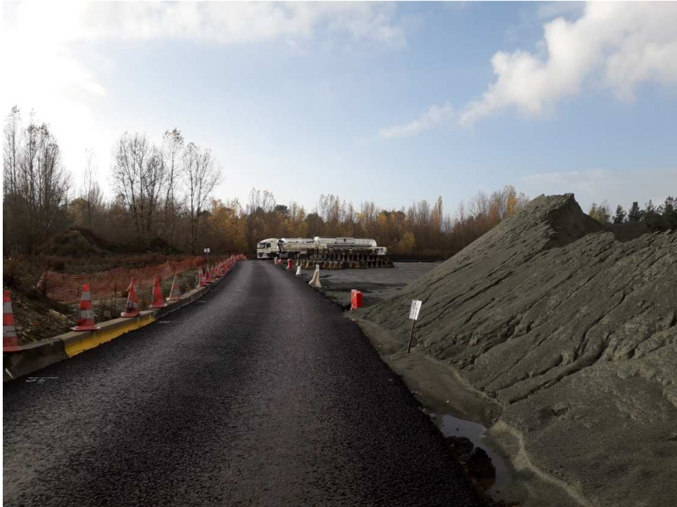
Photographie n° 3 : Vue sur la limite Est de la plateforme (COLAS SO, 03/12/2018)
