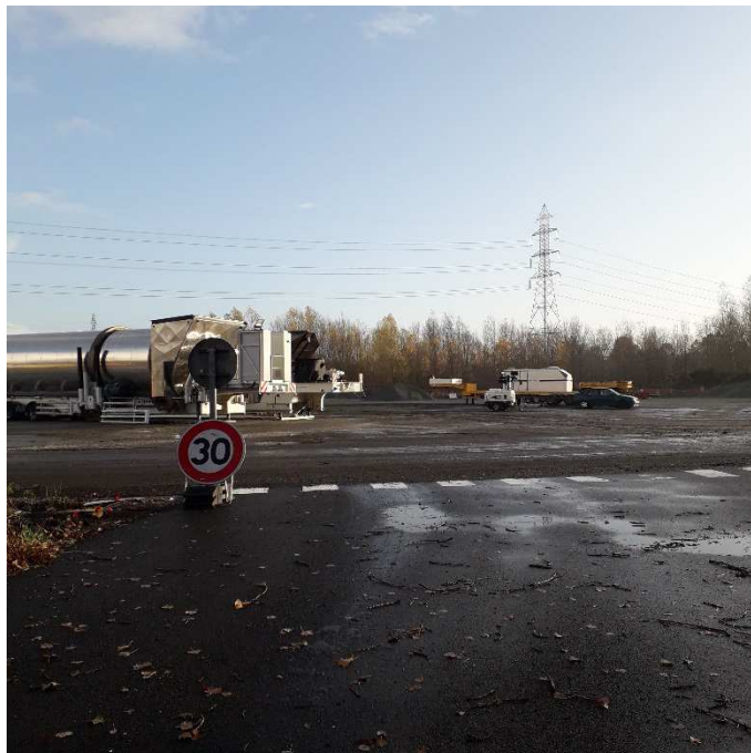
Photographie n° 1 : Vue depuis l'entrée Sud de l'Autoroute (zone Sud-Ouest plateforme) (COLAS SO, 03/12/2018)
